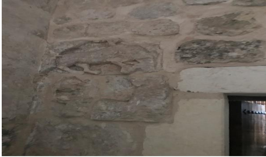
Resim 4: Emir Hamamı girişi “sarı inek” kabartması
