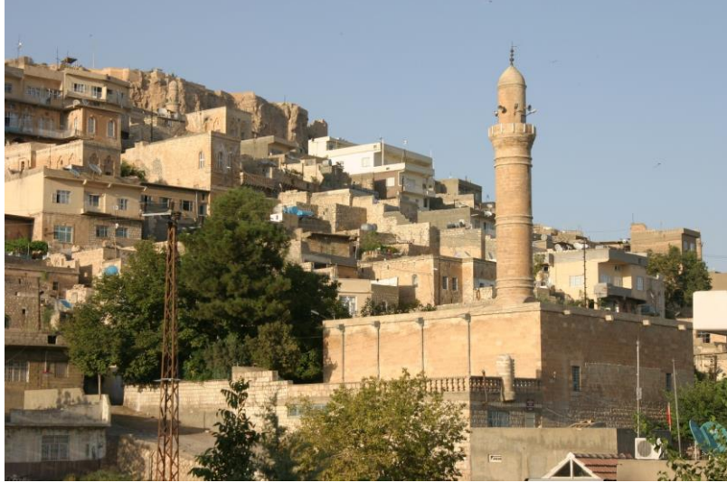
Foto3: Şehitlik (Necmeddin-Asfar Camisi) Güneybatıdan Görünüş
