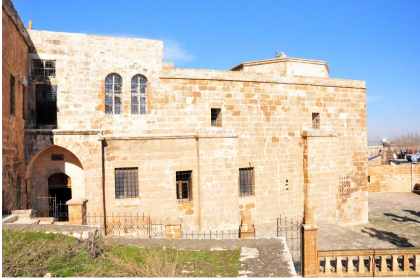
Foto 7: Hatuniye Medresesi ve Türbenin Güney Cepheden Görünüş
