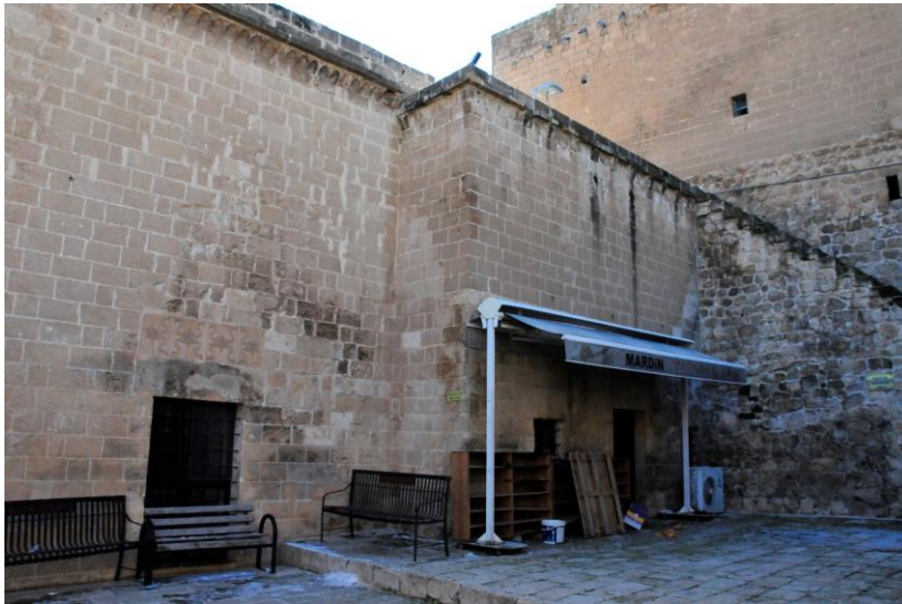
Foto 28: Melik Mahmud Cami Türbesi Giriş Cephesi
