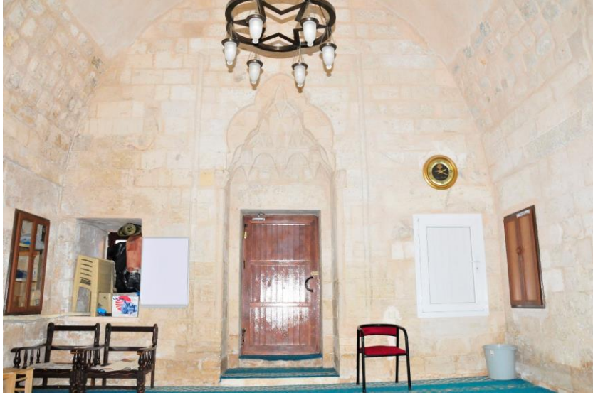
Foto 29: Melik Mahmud Cami Türbesi Kuzey Duvarının Görünüşü
